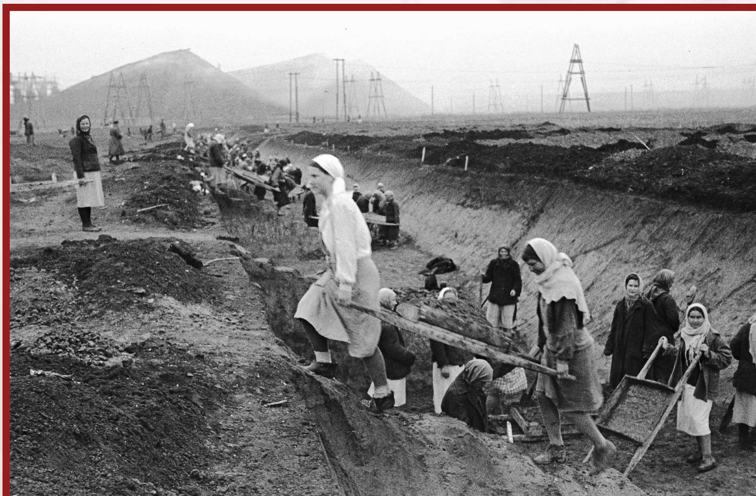
Строительство противотанковых рвов в районе Донбасса.
