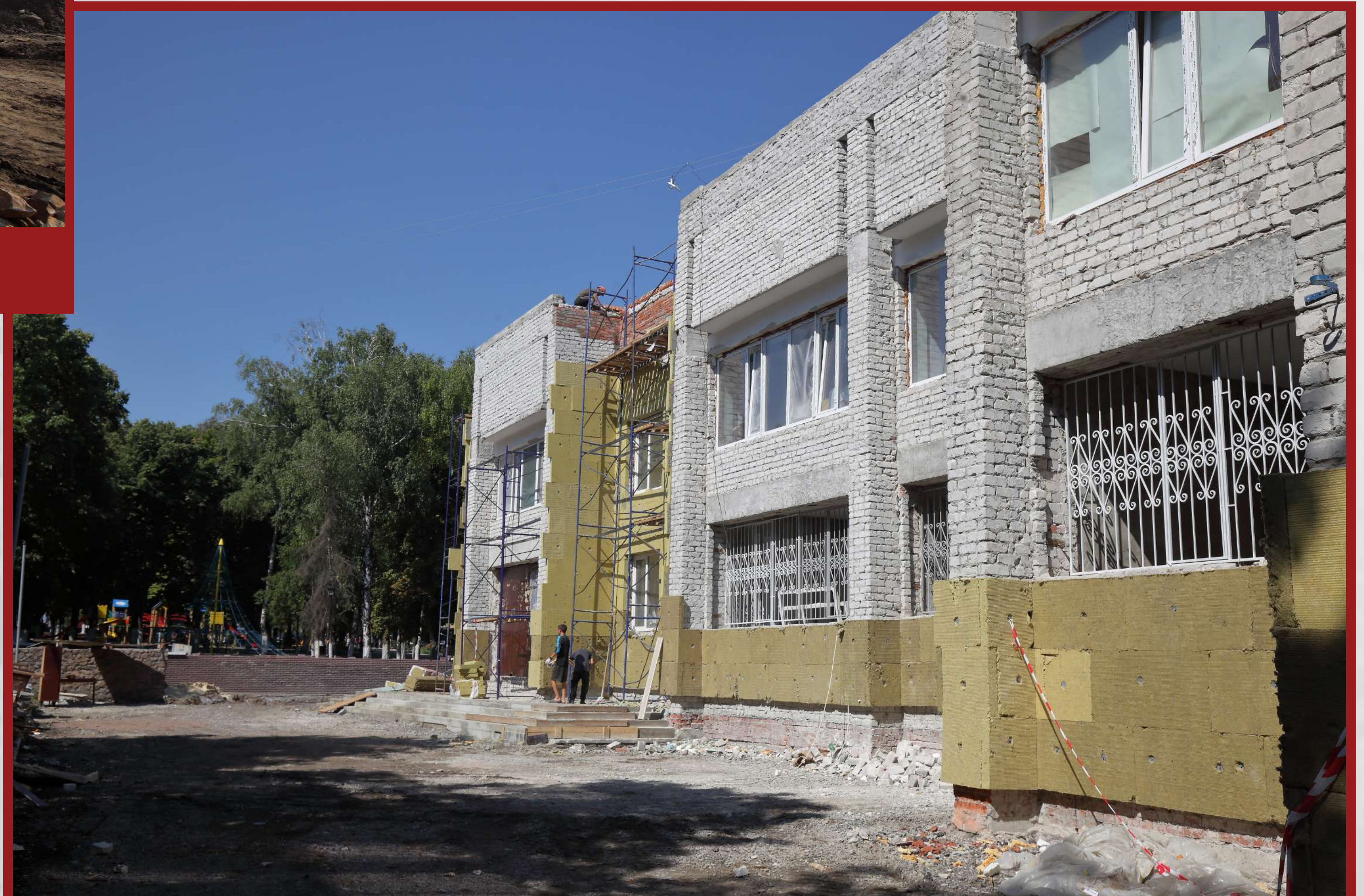
Восстановление Дворца культуры железнодорожников, повреждённого в ходе боёв за город.
